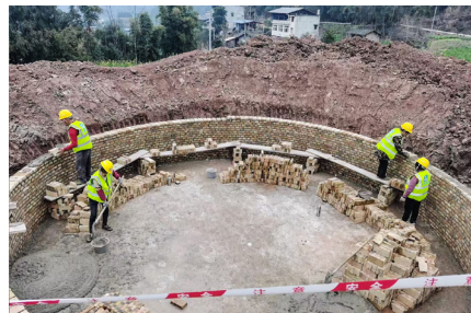
▲中江县 2024 年高标准农田建设项目蓄水池砌筑施工
