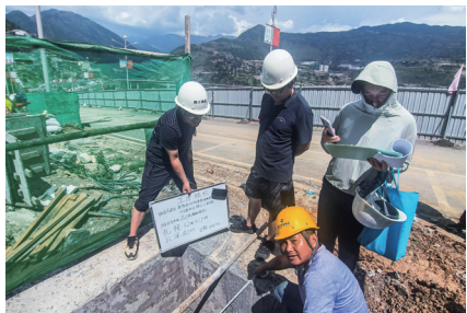
▲金阳中学滑坡抗滑桩孔验收
