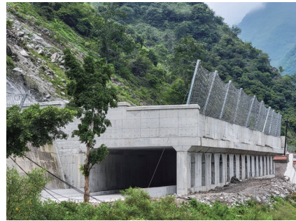
▲ 大渡河瀑布沟水电站右岸高线公路边坡地灾治理工程施工
