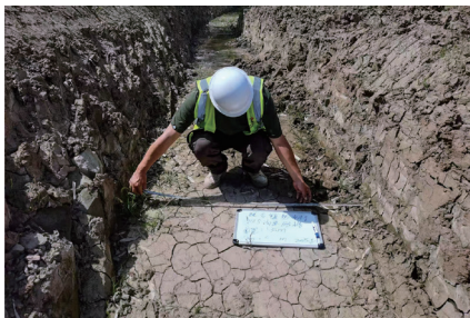
▲中江县 2024 年高标准农田建设项目排灌渠开挖验槽
