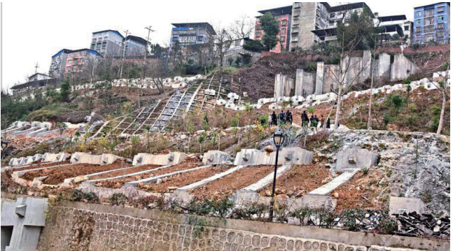
▲ 大渡河瀑布沟水电站右岸高线公路边坡地灾治理工程施工
